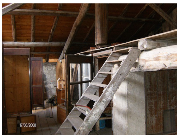
La soffitta con il soppalco
