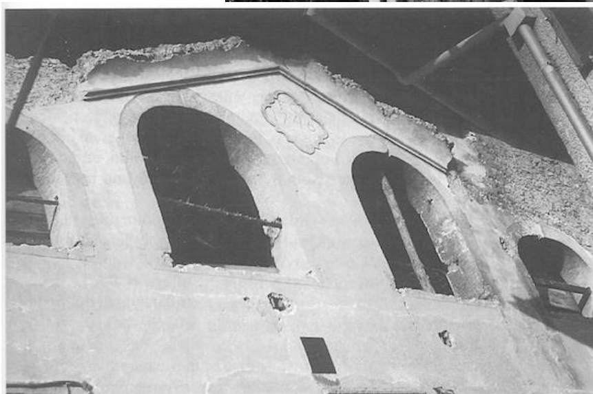
Molina: Casa Colò del 1746, ricordata per la «Gronda del Colò», asilo per fuggiaschi. (Foto Claudio Segalla).
